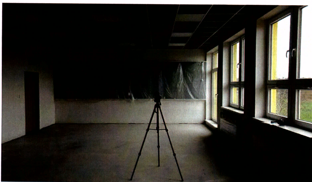
Obr. 3: Ukázka instalace zvukově pohltivého podhledu Sonit SP5V se speciální úpravou zadní strany na ½ plochy
