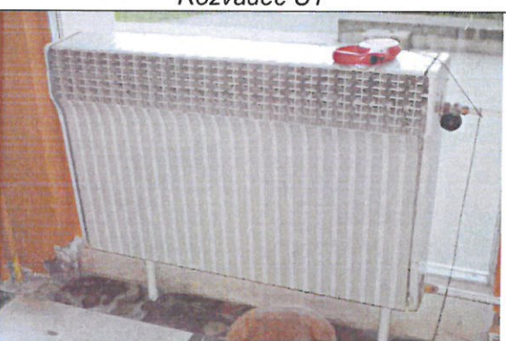
Hliníková otopná tělesa
