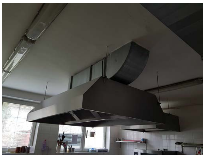
Obrázek 10 – Odtah z kuchyně
