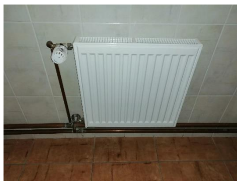
Obrázek 7 - Ocelové deskové těleso
