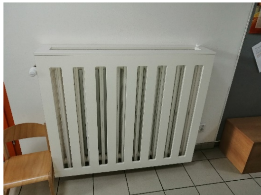
Obrázek 21 - Otopná tělesa v dřevěném ohrazení
