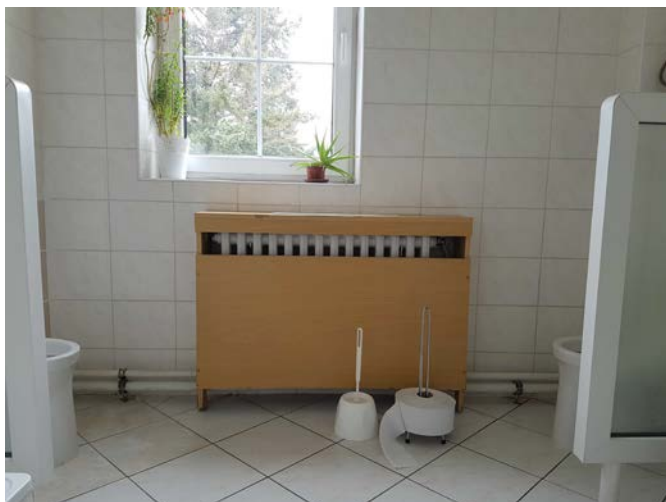
Obrázek 6 - Otopná tělesa v dřevěném ohrazení
