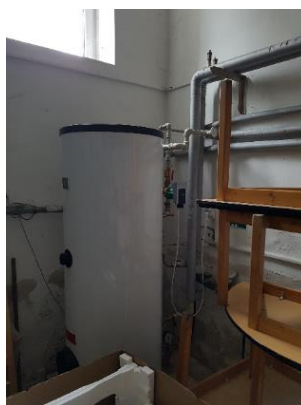
Obrázek 9 – Ohřev teplé vody
