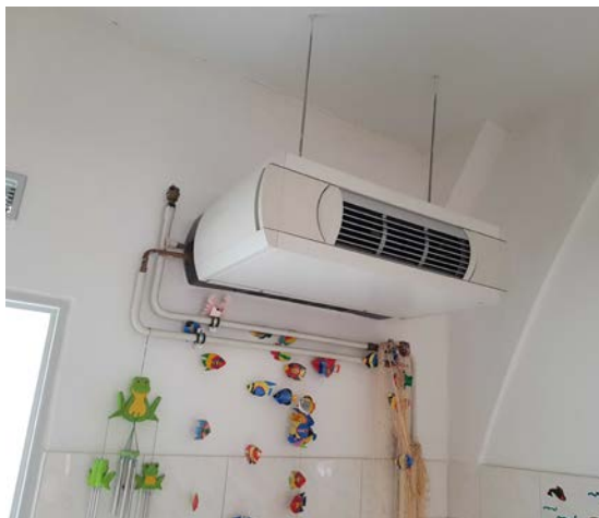
Obrázek 25 – Teplovzdušné vytápění WC
