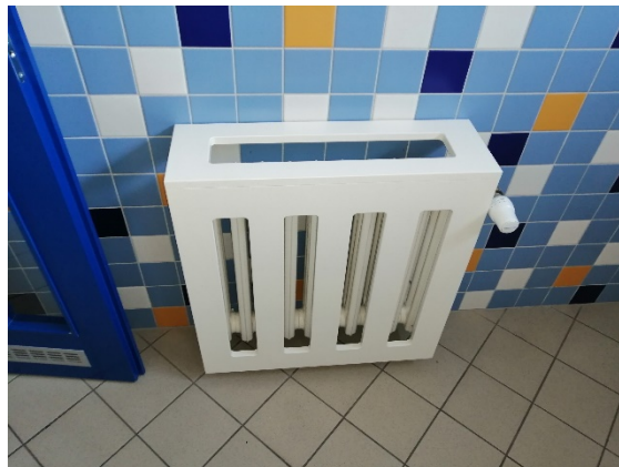
Obrázek 7 - Otopná tělesa v dřevěném ohrazení
