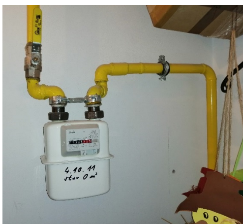
Obrázek 31 – Plynoměrné zařízení
