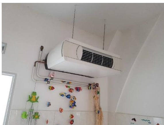
Obrázek 8 – Teplovzdušné vytápění WC
