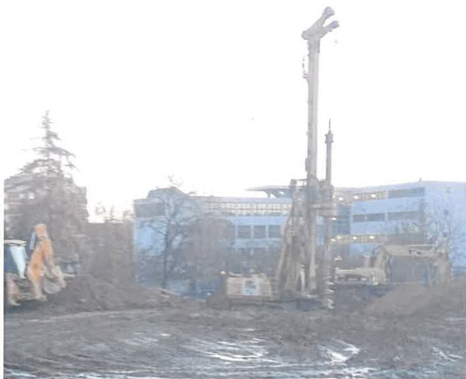
Fotografie č. 2 - provádění pilot bez výpažnice
