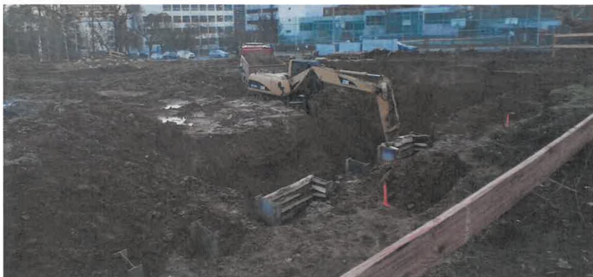
Fotografie č. 2 - realizace zápor
