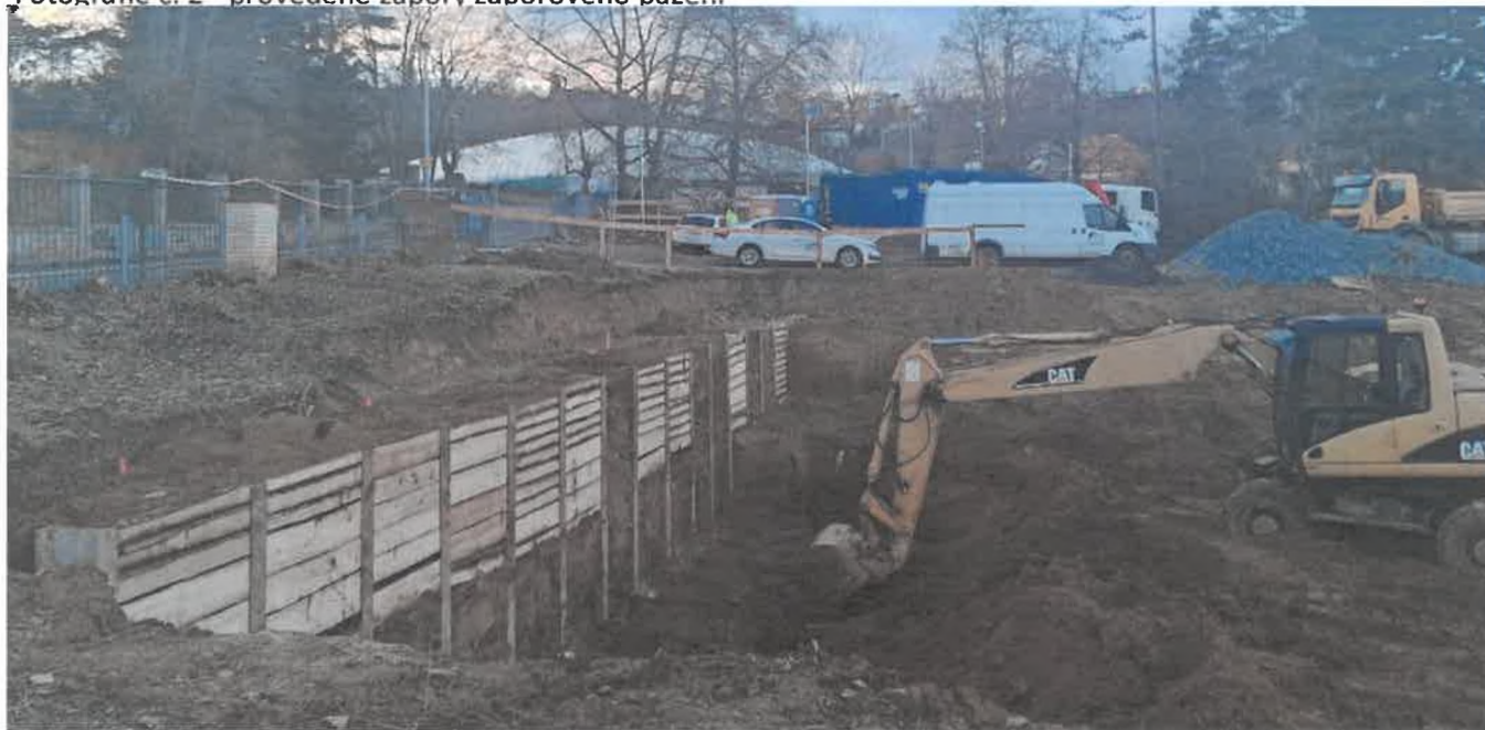
Fotografie č. 2 - provedené zápory záporového pažení
