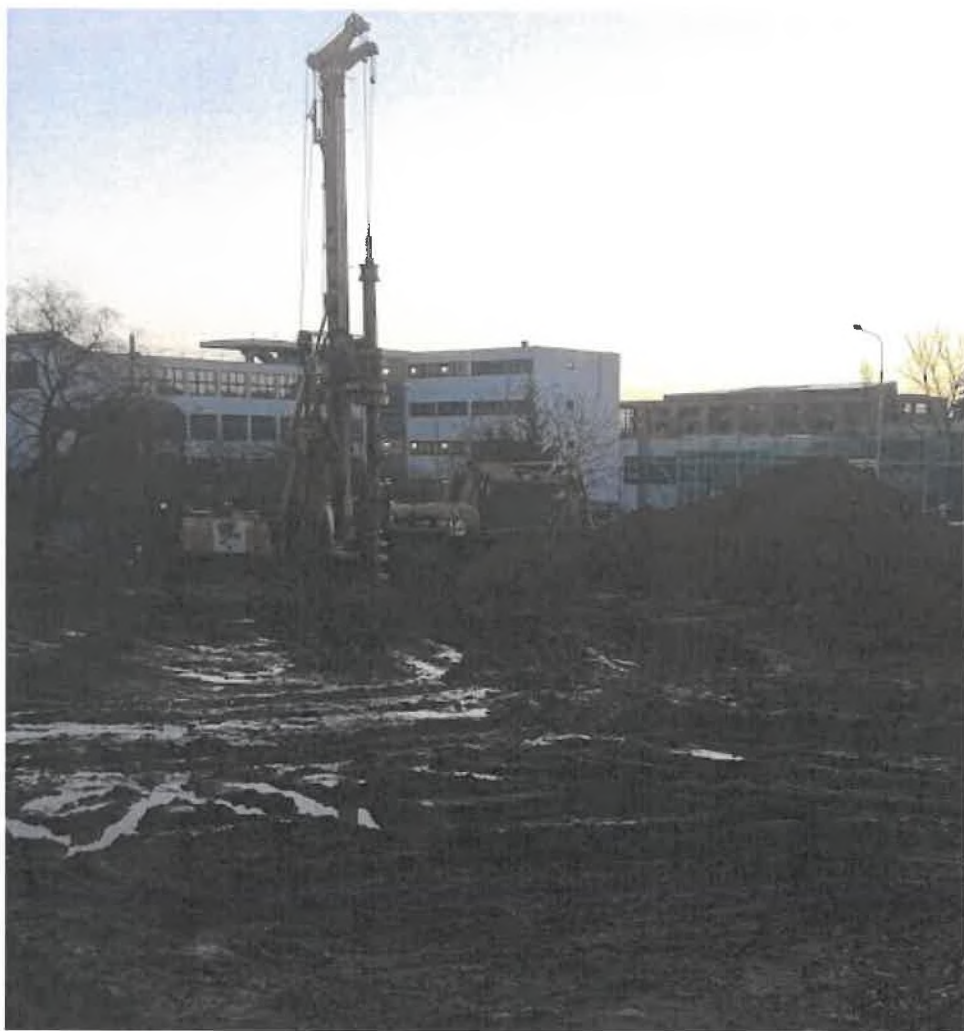
Fotografie č. 2 - provádění pilot bez výpažnice
