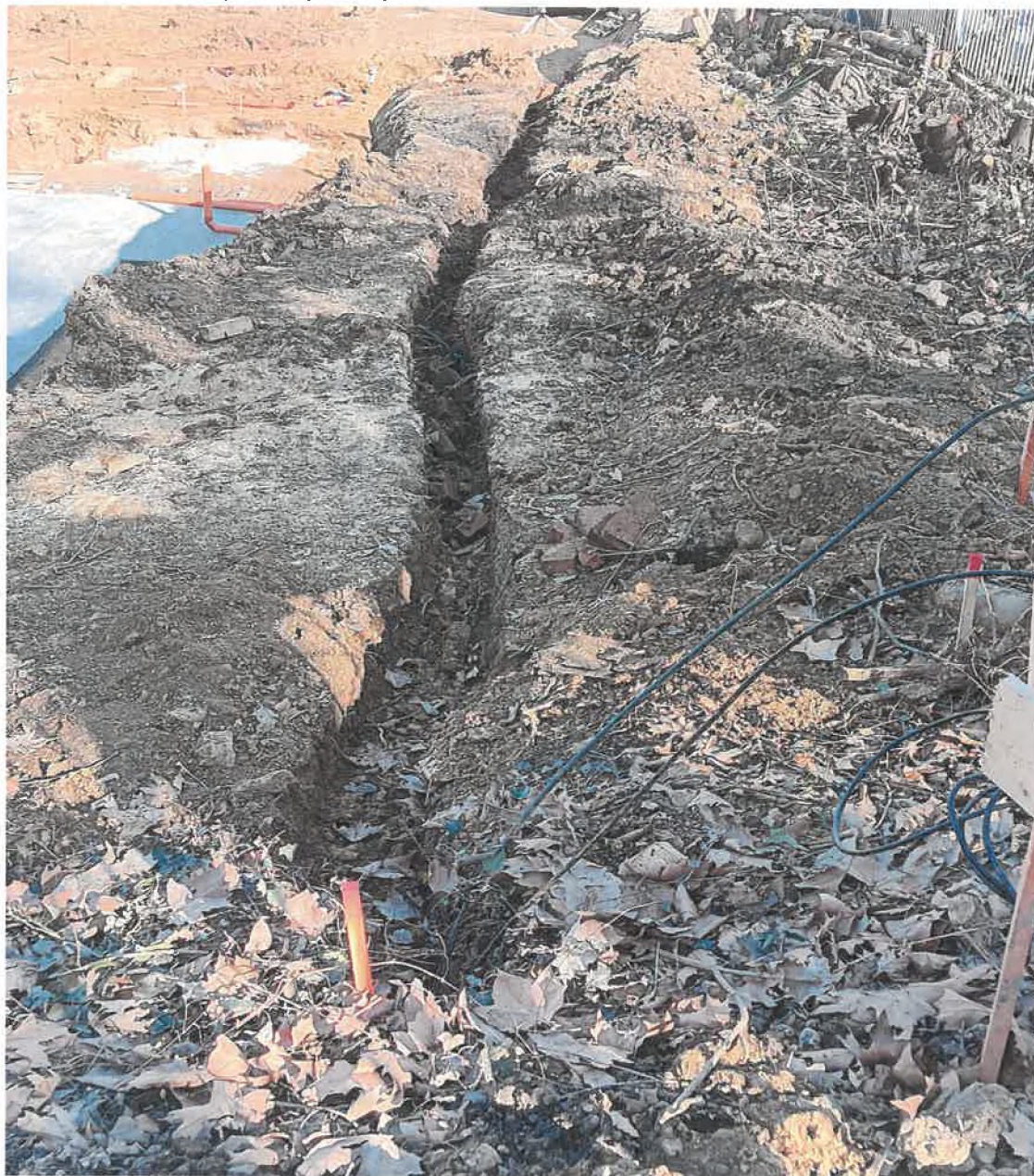
Fotografie realizace přeložky slaboproudého kabelu CETIN
