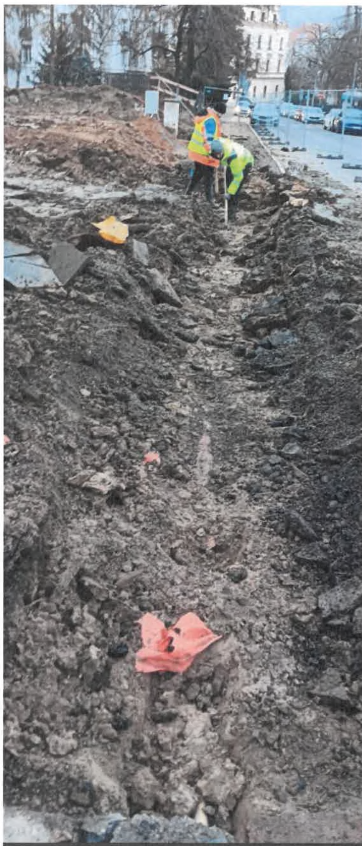
Fotografie č. 1 - provádění přeložky kabelu NN
