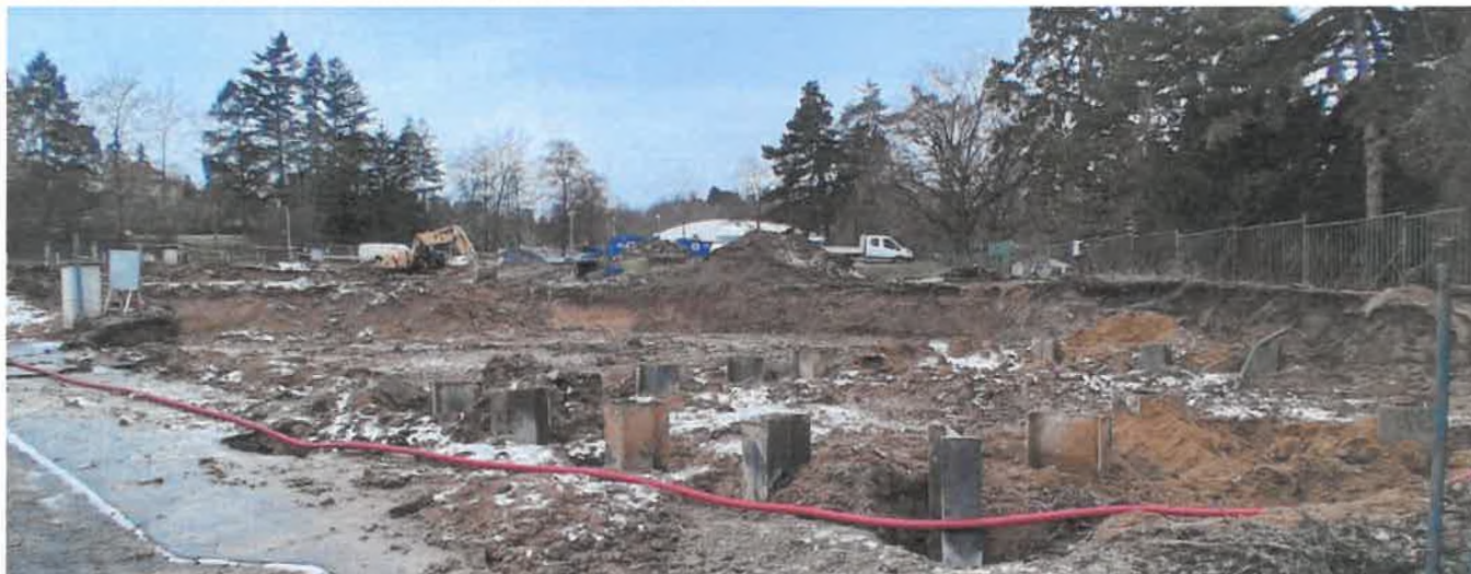
Fotografie č. 2 - provedené zápory záporového pažení
