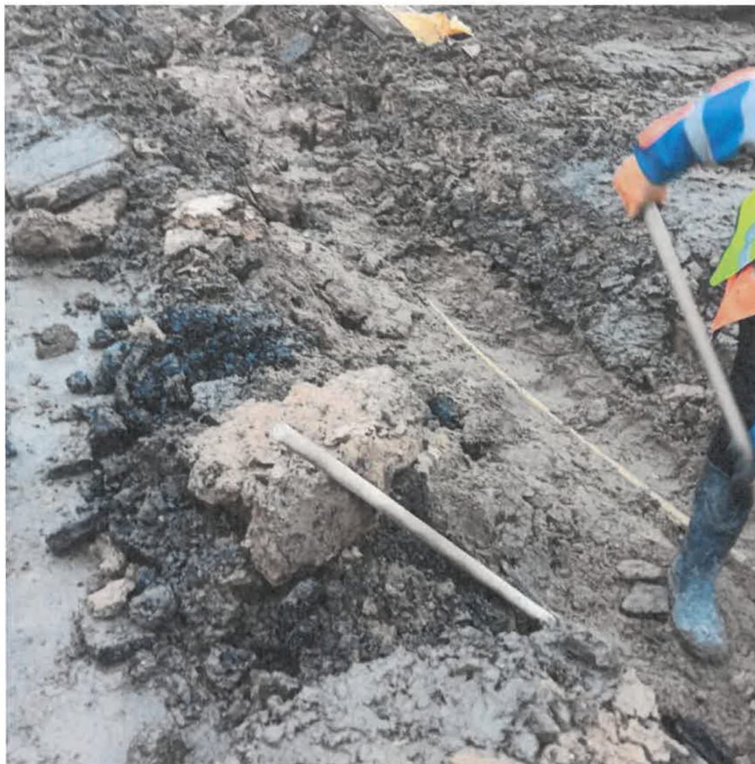
Fotografie č. 2 - provádění přeložky kabelu NN
