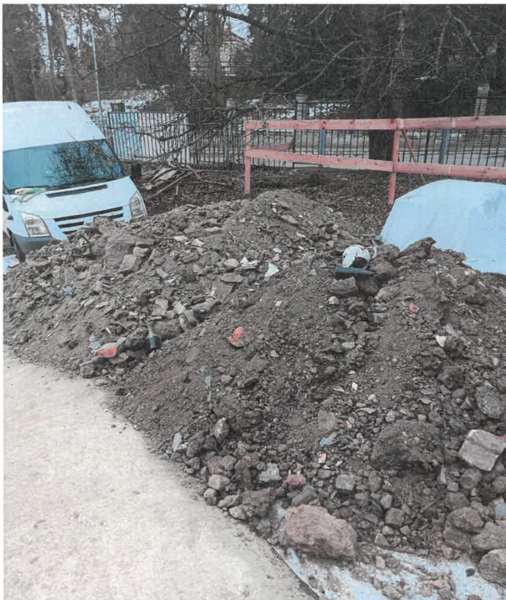
Fotografie č. 1 - kontaminovaná zemina směsným odpadem
