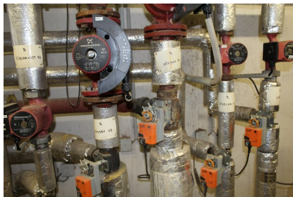
Obrázek 27 - Oběhová čerpadla na rozdělovači
