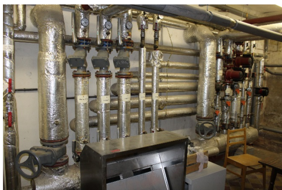
Obrázek 6 - Rozdělovač a sběrač v budově školy
