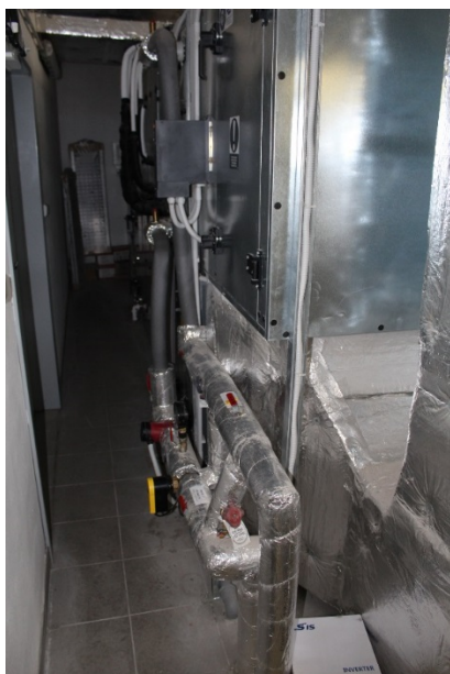
Obrázek 12 - VZT jednotka pro kuchyň, pohled A
