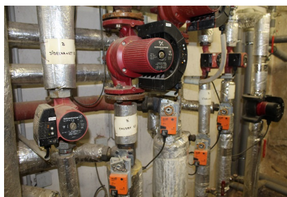
Obrázek 7 - Oběhová čerpadla
