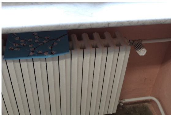
Obrázek 8 - Litinová otopná tělesa v budově
