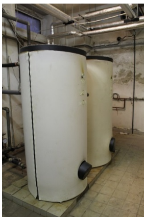
Obrázek 10 - Akumulační zásobníky teplé vody
