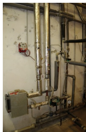
Obrázek 11 - Deskový výměník ohřevu teplé vody
